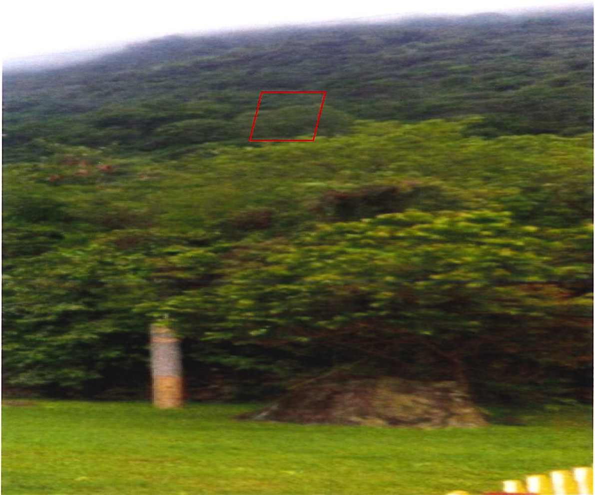
第14號鐵塔現況照片(未施工)
